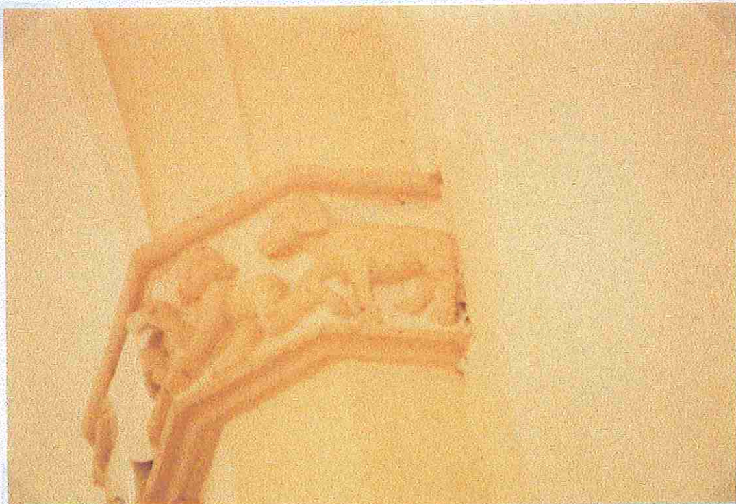
Fig.108 : Nef. Chapiteau R. Partie droite. Chien.
